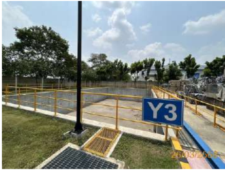
ภาพที่ 2-28 บ่อหน่วงน้ำฝนของโครงการ
